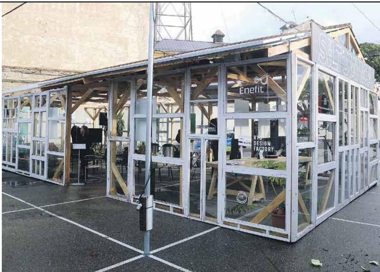
Būve ir ilgtspējīga un vieda, veidota no otrreiz izmantotiem logiem, aprīkota ar saules enerģijas paneļiem un unikāliem sensoru prototipiem gaisa kvalitātes mērīšanai.
